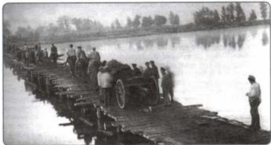
Переправа наступающих на Варшаву частей Красной Армии через реку Западный Буг. 1920 г.
