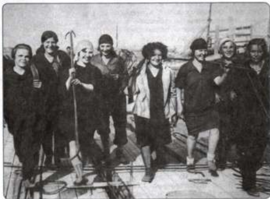
Женская строительная бригада. 1931 г.
