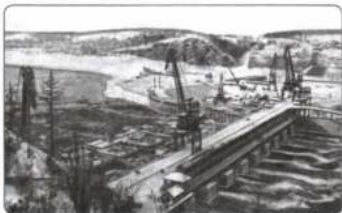
Строительство Братской ГЭС
