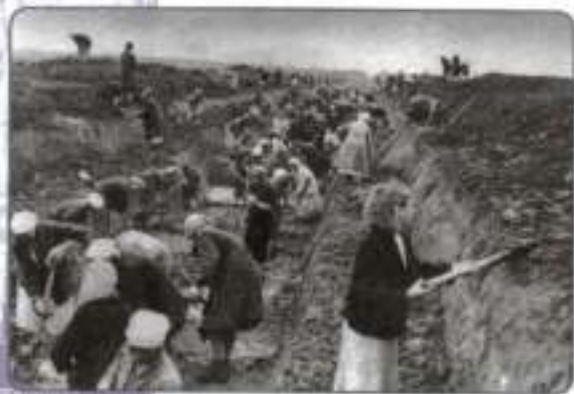
Москвичи на строительстве оборонительных сооружений. 1941 г.
