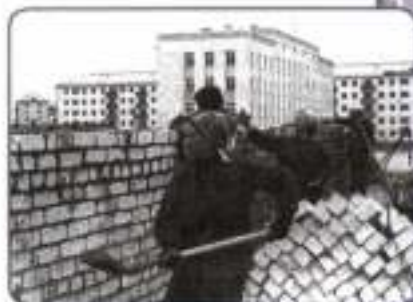
На стройке. Начало 1960-х гг.
