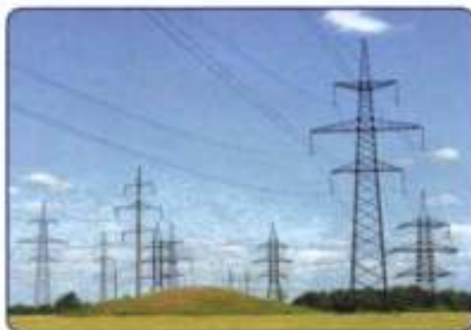
Рис. 39. Высоковольтная линия электропередачи
