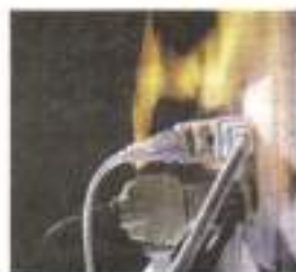
Рис. 89. Короткое замыкание в электропроводке
