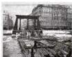
Разрушенный Египетский мост
