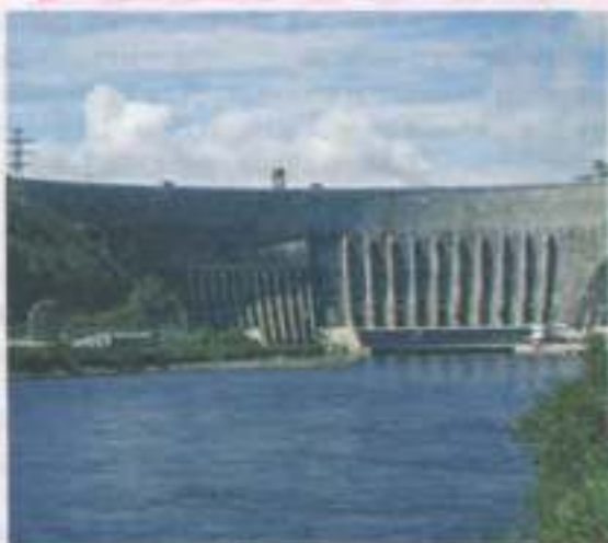
Рис. 124. Плотина Саяно-Шушенской ГЭС
