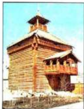
Башня Якутского острога
