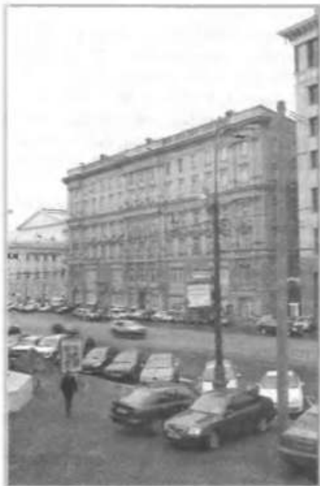
Фасад здания МЧС
