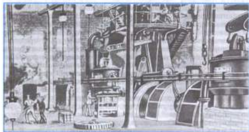
Машинный зал центральной электростанции в Берлине. 1890 г.
