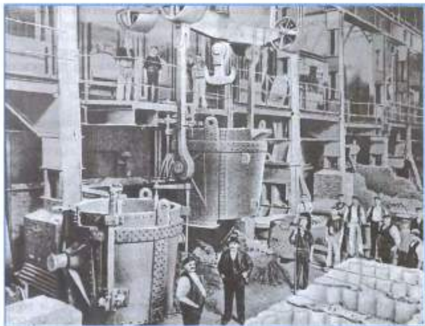
Мартеновский цех завода Вихерс. 1894 г.
