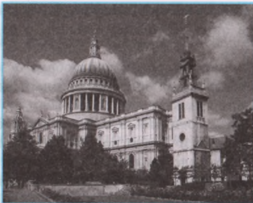
Собор Святого Павла в Лондоне. Архитектор К. Рен. 1675–1708 гг. Современный вид
