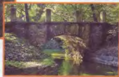
Каменный арочный мост
