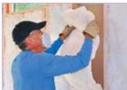
Рис. 9.13. Уменьшение потерь тепловой энергии — утепление стен домов
