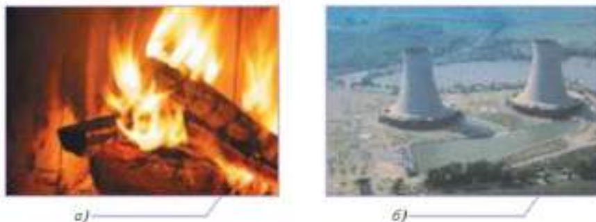
Рис. 9.4. Первичная тепловая энергия горячей древесины (а); вторичная тепловая энергия, выделяемая градирнями (б) — сооружениями для охлаждения воды атмосферным воздухом
