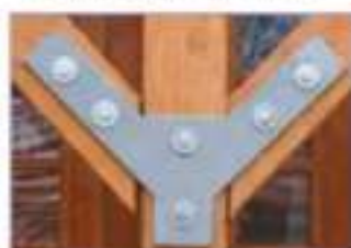
Рис. 6.4. Крепление деталей из древесины на болтах
