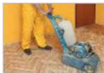
Рис. 5.13. Электрифицированная шлифовальная машинка (а); шлифовальная машина для подготовки полов к лакированию (б)
