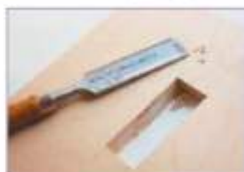
Рис. 5.11. Выполнение отверстия долотом
