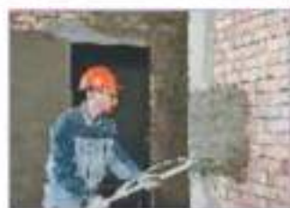
Рис. 7.6. Наружное оштукатуривание: а — выравнивание штукатурки тёркой; б — виды кельм и тёрки; в — разбрызгиватель штукатурки
