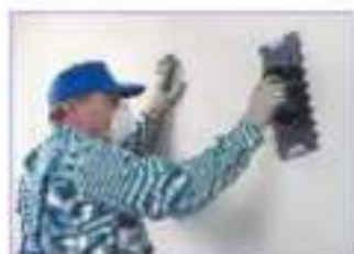
Рис. 7.6. Наружное оштукатуривание: а — выравнивание штукатурки тёркой; б — виды кельм и тёрки; в — разбрызгиватель штукатурки
