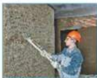
Рис. 5.16. Технология лепки из глины (а); нанесение штукатурки (б)
