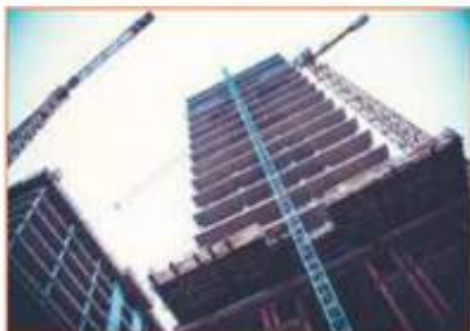
Рис. 7.1. Монолитное строительство с применением химического фрезерования
