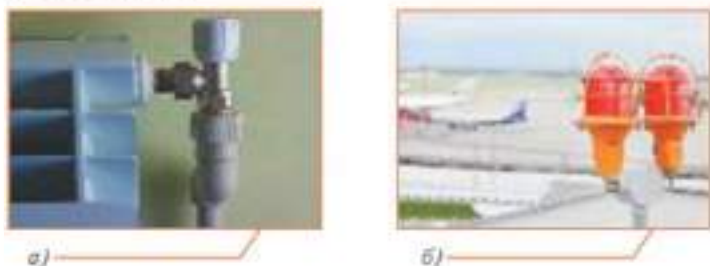
Рис. 4.9. Автоматический регулятор давления в системе водоснабжения дома (а); сигнальная аппаратура (б)
