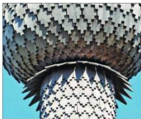
Лемех — покрытие крыши из деревянных дощечек
