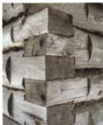
Соединение брёвен «ласточкин хвост»
