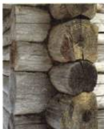
Соединение брёвен «замок»
